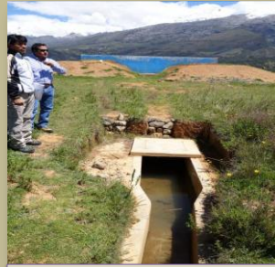
Canal de salida del reservorio
