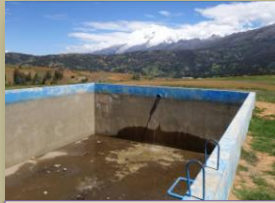
Reservorio de 200 m3.
